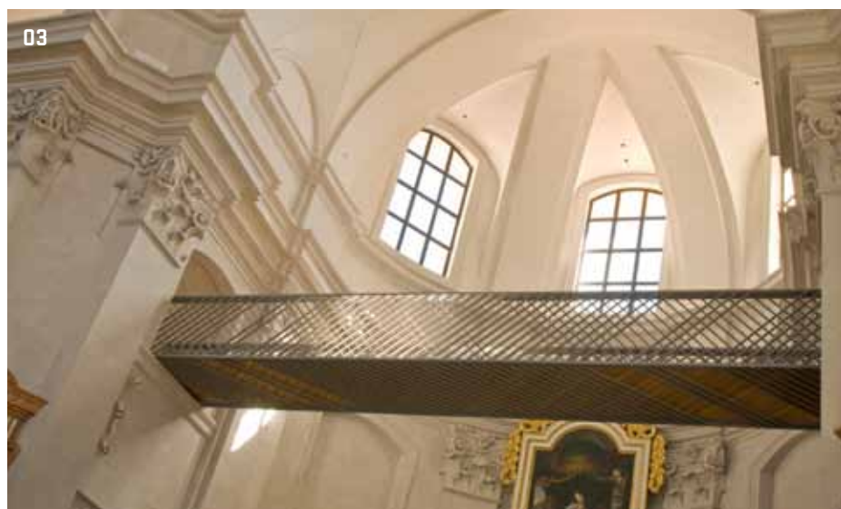
03, 04 > Lávka přes příčnou loď byla pouze vložena na nosné zdivo
